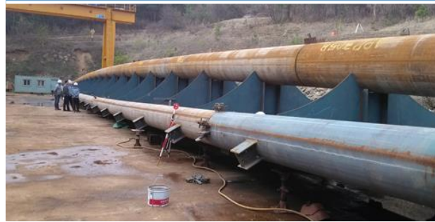
STEP 5 : Main Pipe Girder 가조립
