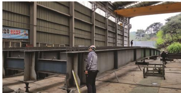
STEP 5 : 공장 가조립
