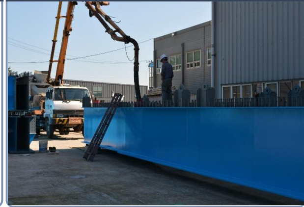
이중합성부 콘크리트 충전
