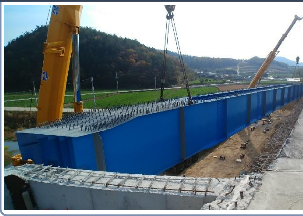
지조립 및 거더 설치
