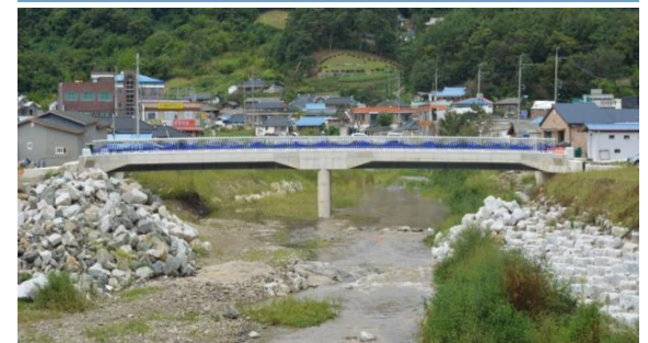
STEP 9 : 거푸집 설치 및 준공
