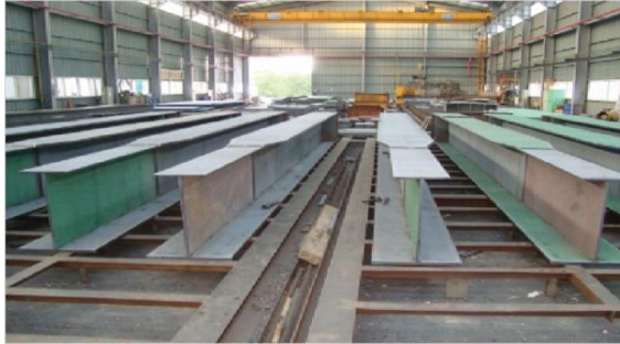
STEP 2 : 거더 조립 및 용접
