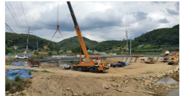
STEP 6 : 거더 설치
