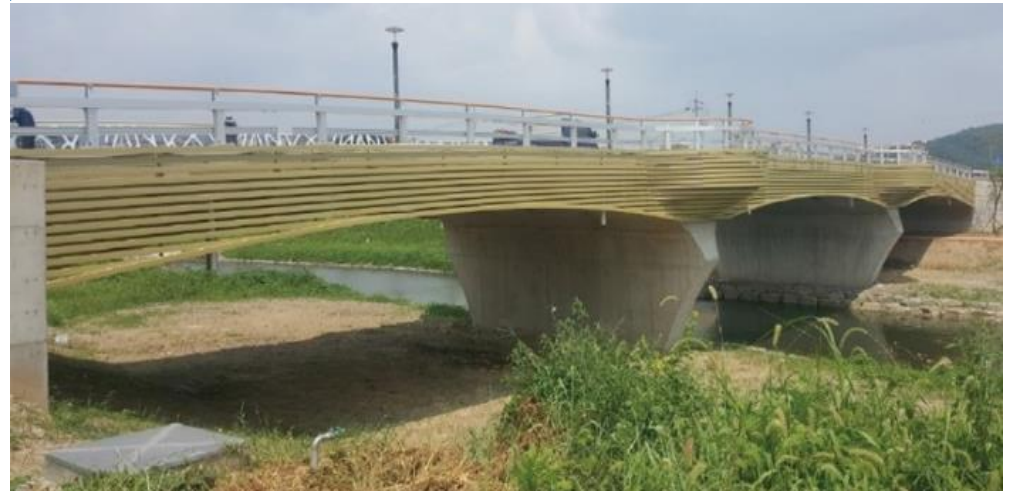
순천만국가정원 진입교량 설치공사
